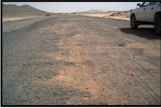
**Figure 2.** Dégradations sur la partie réalisée avec CTP 1981. Route Transsaharienne
